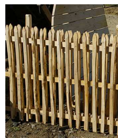
Clôture ganivelle fixée sur tasseaux horizontaux
